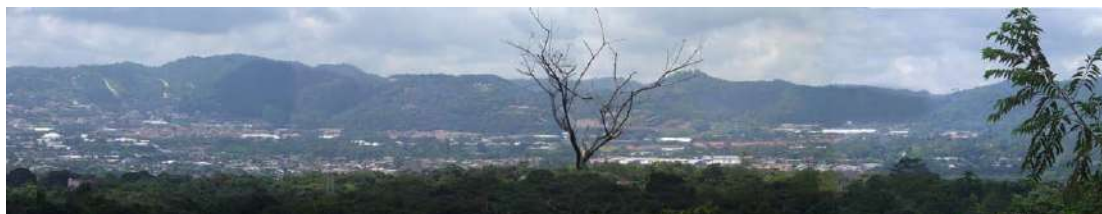
Avance de la urbanización
