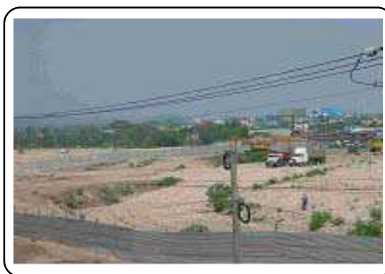
Foto: Terracería en Finca El Espino Intervención en terreno propiedad de la familia Dueñas, al sur de la finca.
