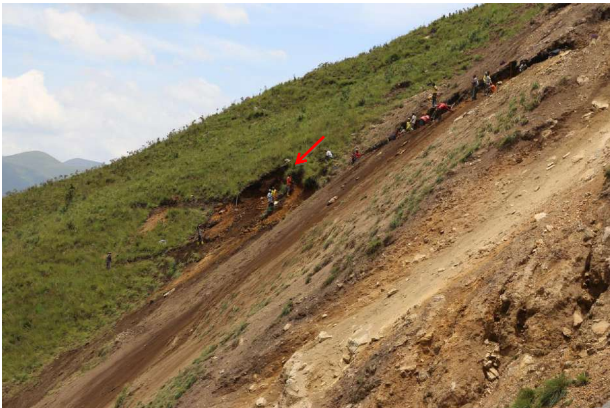
Photo 35 : Ouverture d'un nouveau terrain d'exploitation. Des conseils techniques sont nécessaires pour aider les mineurs à localiser les gisements d'or et planifier l'extraction en conséquence
