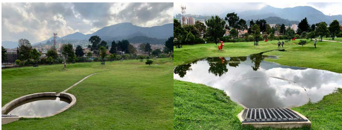
Figura 5.1: SUDS (cuenca seca de drenaje extendido) en Parque Metropolitano San Cristóbal Sur, Bogotá, Colombia.
