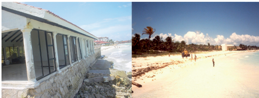
Figura 3.24 - Vista de una fracción del litoral costero al sur de Playa del Carmen que corresponde a Playacar en año 1971 (izquierda) y en el año 2005, en donde se observa la ubicación de infraestructura sobre la duna y la afectación a las instalaciones.
