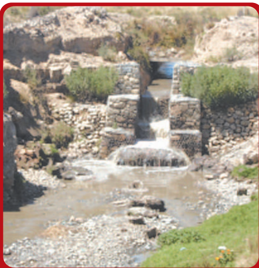
Descarga lateral: Planta de Puchukollo
